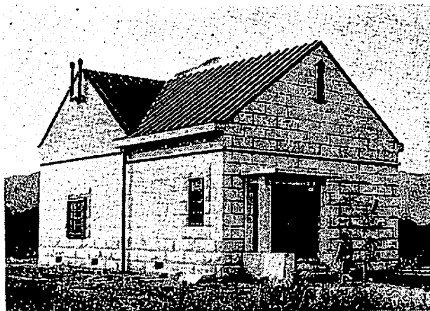
第26図 標準磁気儀室 鉄釘など磁氣的物質を一切使わない (気象庁柿岡地磁気観測所)
