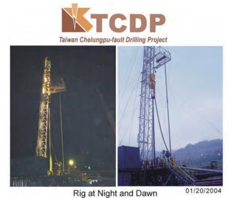
図3. 台湾中央部(台中)で行われている大深度断層貫通掘削の様子。掘削は24時間で進行するため、夜間は煌煌とライトアップされている。
